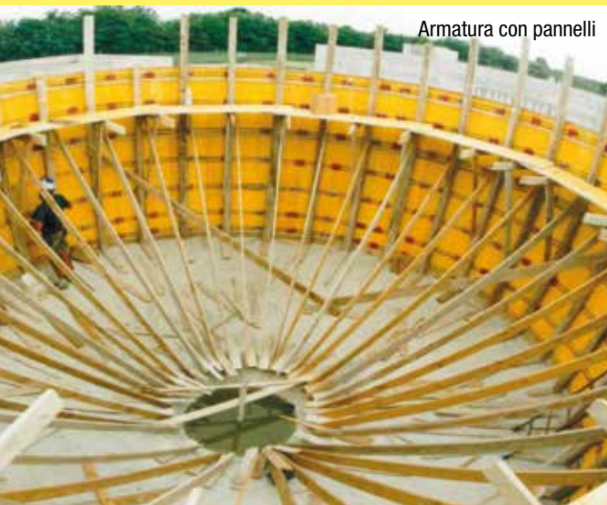
Armatura dritta a faccia vista
